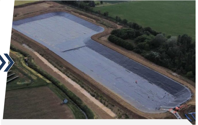
Invaso a lavori terminati
