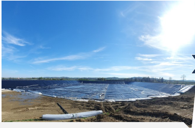
Posa del TNT in polipropilene e dell'HDPE
