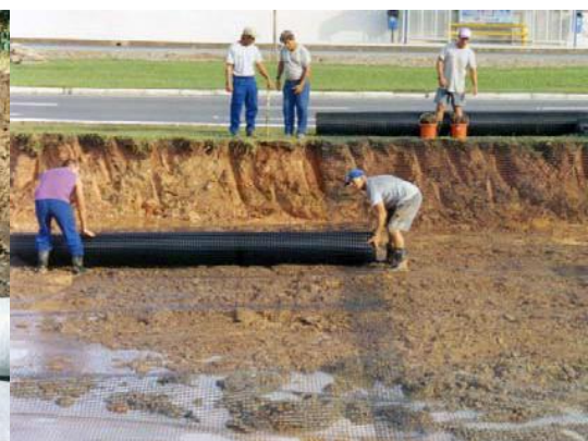
Riduzione della fondazione granulare
