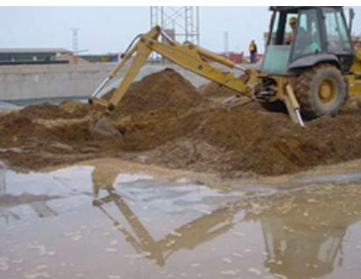
Accesso su suolo bagnato/soffice
